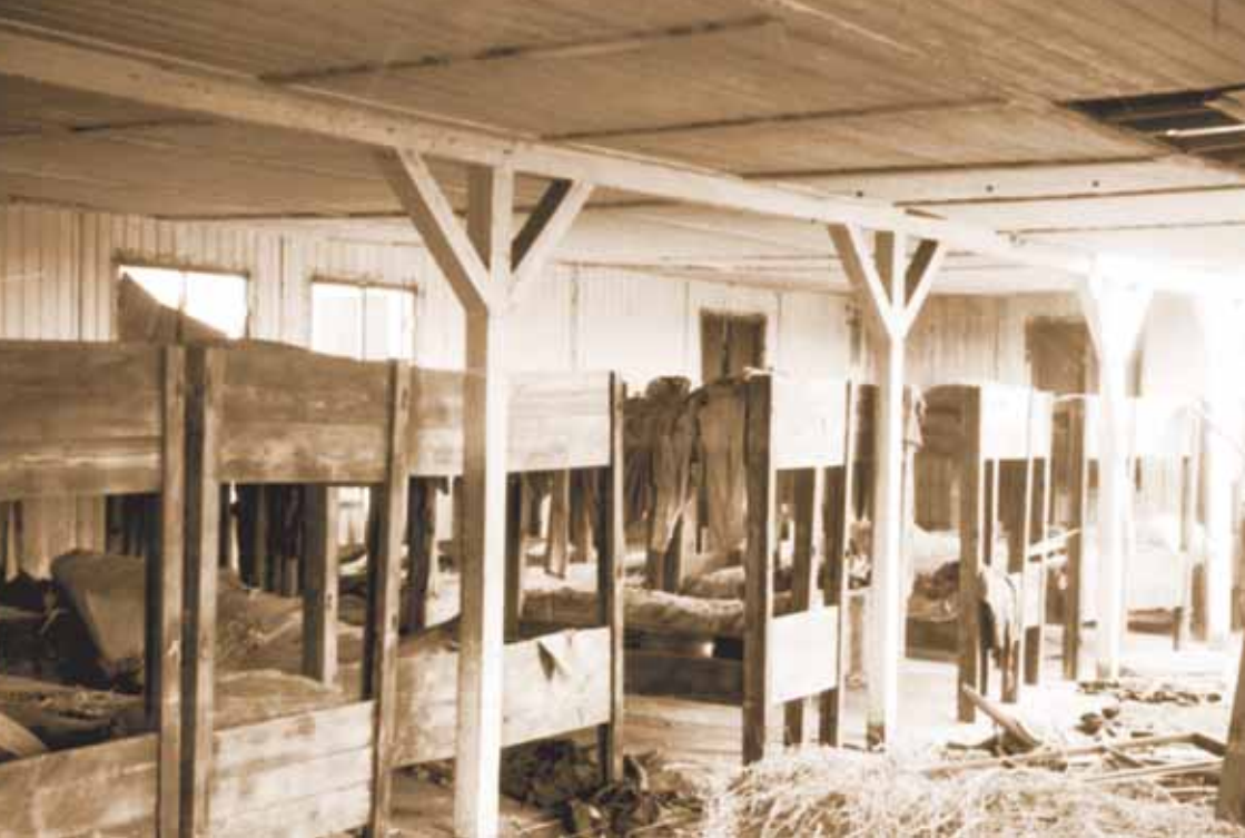
Vue dans l'intérieur d'un baraquement vide, mars 1946 Source: Photothèque de la Ville de Luxembourg, collection Tony Krier
