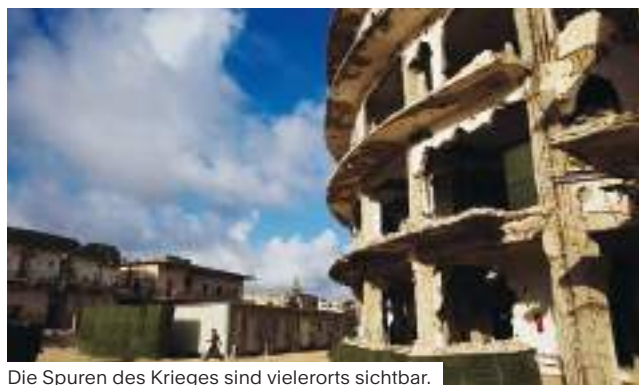
Die Spuren des Krieges sind vielerorts sichtbar. Hier ein zerstörtes Viertel in Mogadishu .
