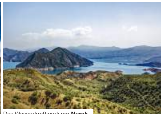
Das Wasserkraftwerk am Nurek-Stausee versorgt fast das ganze Land mit Elektrizität.
