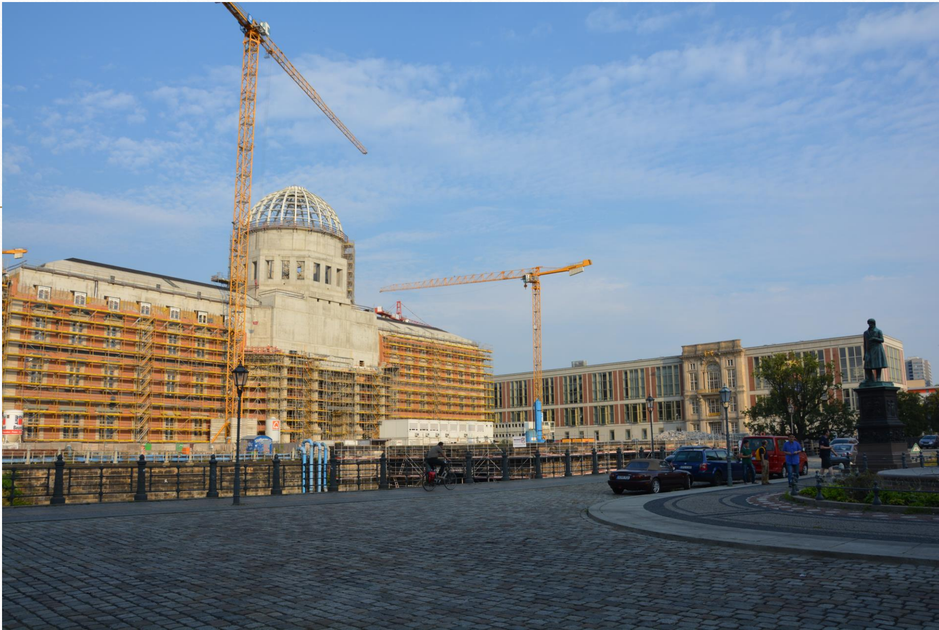
Baustelle Berliner Schloss mit dem ehemaligen Staatsratsgebäude im Hintergrund
